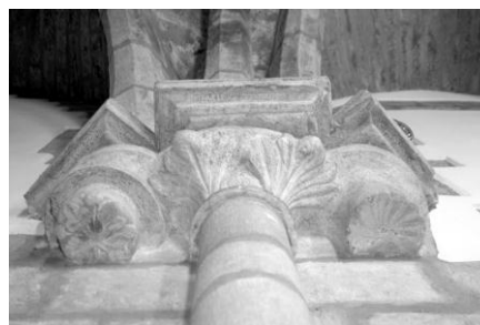
Foto 6 – mísulas de suporte da abóbada
