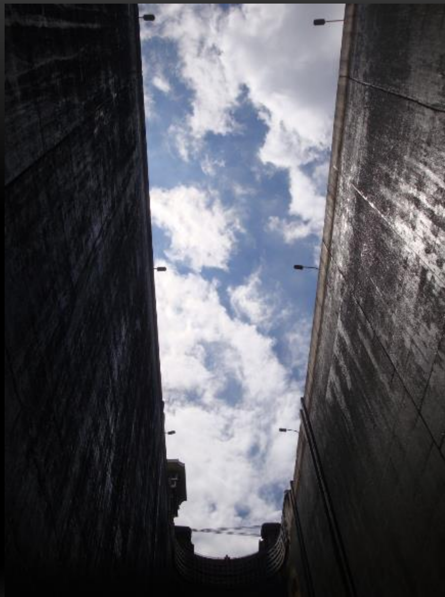
"Túnel da ilusão" - Barragem de Crestuma no Douro - Ana Paula Rodrigues
